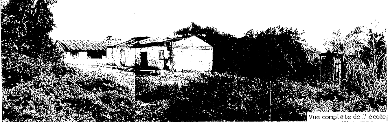
Vue complète de l'école
