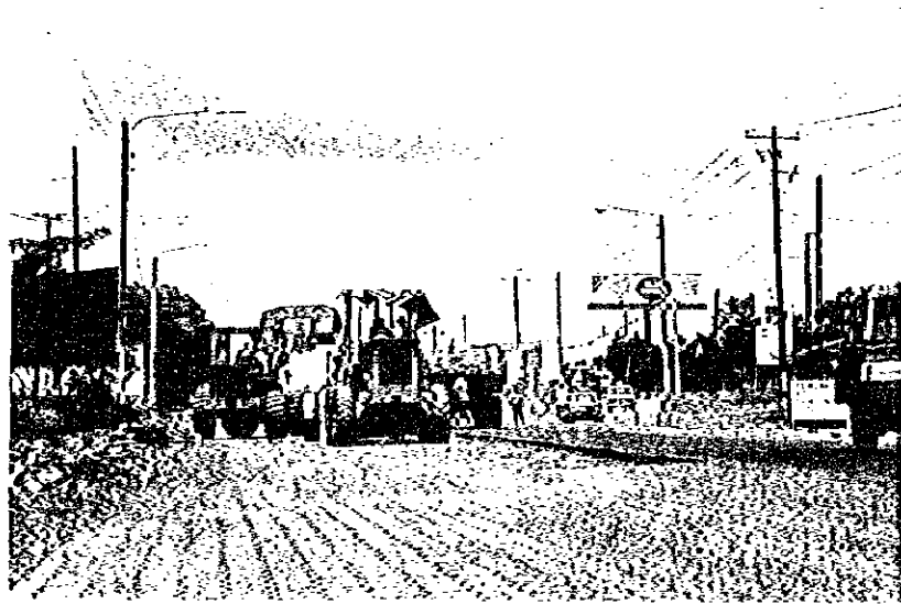
13. “アドキン”の改良工事の状況
