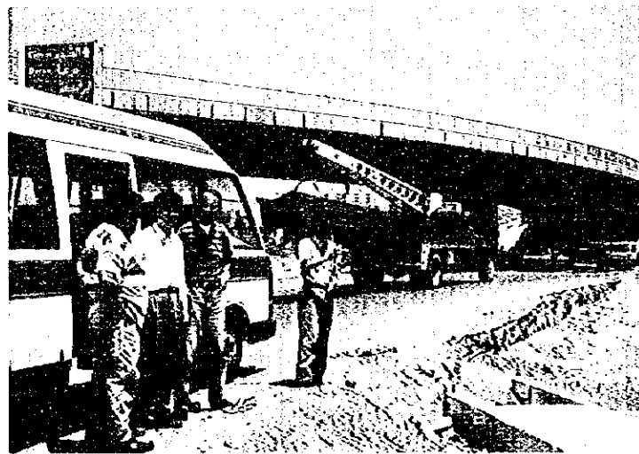
写真-18 工事中の新ヨルダン街道（第8インターチェンジ）
