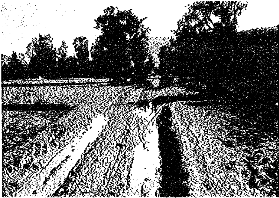
チャンパサック県サナソンブン郡 C-1 ナカハム村 雨期には通行不可能となる村落道路。 乾期にも水が残っている。
