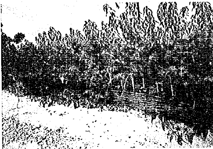
流出土砂対策用の植林地帯と竹柵工
