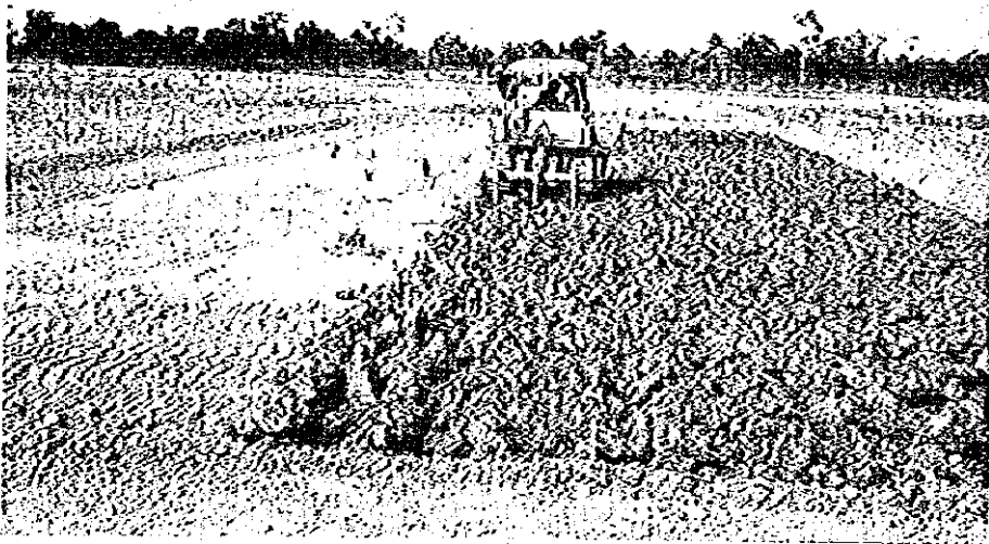
写真は、リッパードーザーによるリッピング状況。
