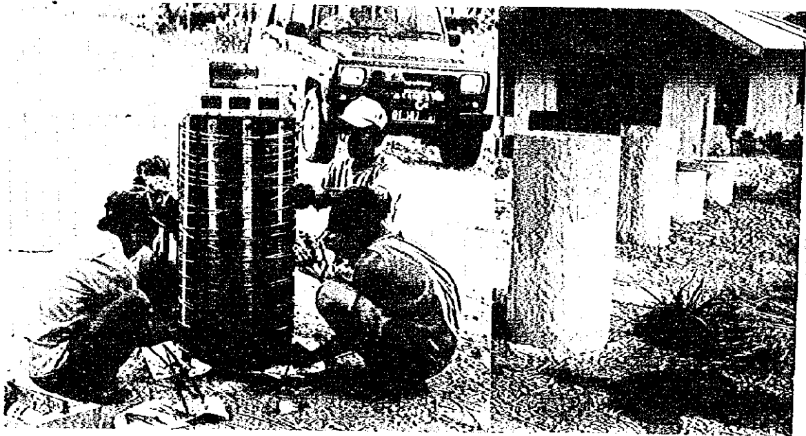
写真は金森短期専門家の指導による鉄筋コンクリート管作成状況。
