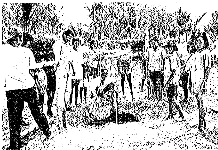
写真は、キアエ村の農民グループによる井戸掘削状況である。
