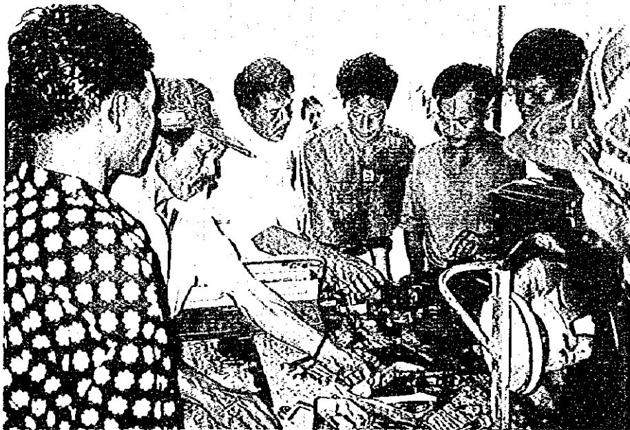
C/Pにより、村のオペレーター、整備士への、ハンドトラクターのエンジン分解、組立指導。
