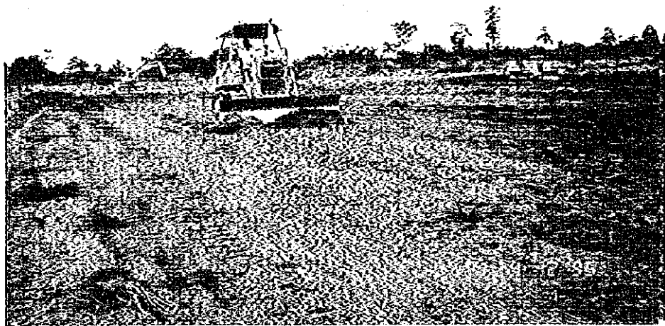
直営工事 重機による水田造成（サブラコア村）
