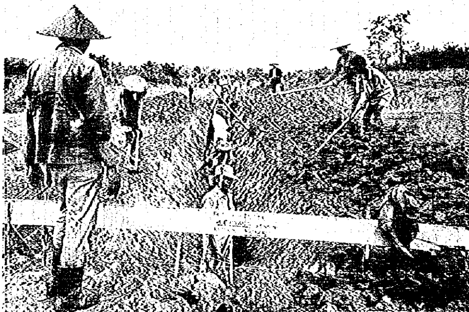
農民グループ工事 用水路掘削（キアエア村）
