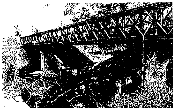
Mbuo:旧橋の上に架けられた仮設ベイリー橋
