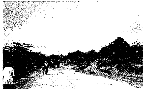
南岸幹線道路状況 (Kibiti 付近)
