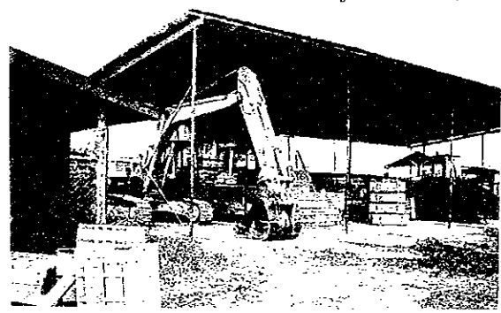
Mabibo の MOW の建機センター (ダルエスサラーム市内)
