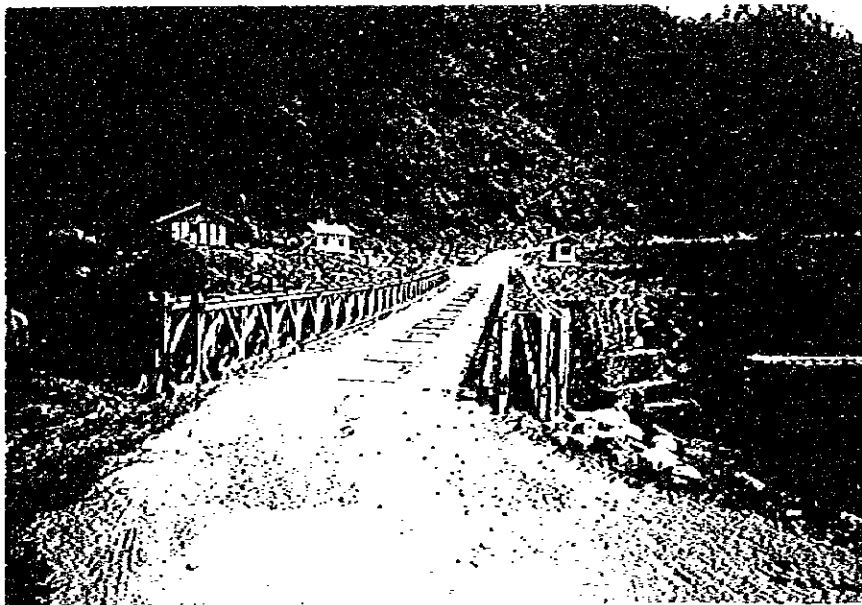
写真-42 No.19、Chanchey橋、37m。 TS Bailey。 建設年度は1990年で新しい が、橋長37mをTS Baileyで 維持するのは無理がある。
