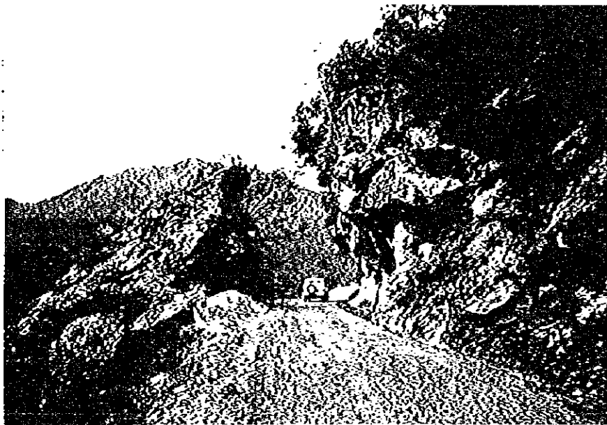
写真一11 急峻な地形を走る既存道路。
