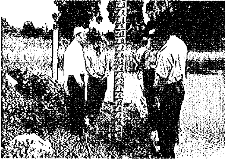
ペカン地区（輪中堤）に設けられた 量水表
