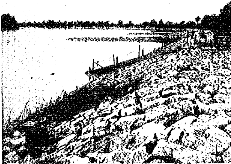
親水を考慮した張り出し水制 （バハン川）
