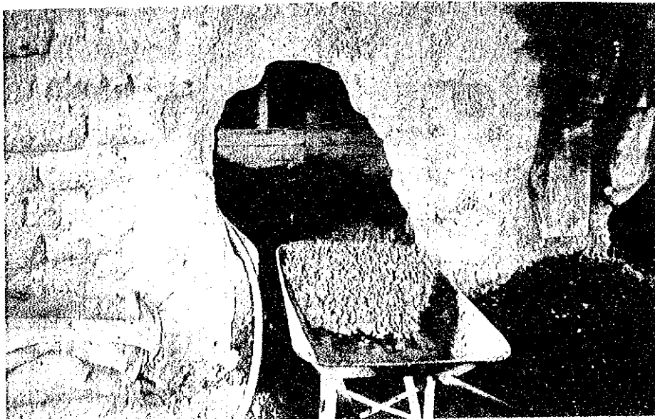
破碎された鉱石を一輪車にてボールミルへ給鉱する。
