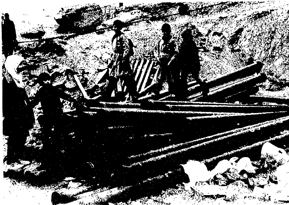
不許可居住地域でのφ100ダクタイル鑄鉄管の敷設現場（T継手）
