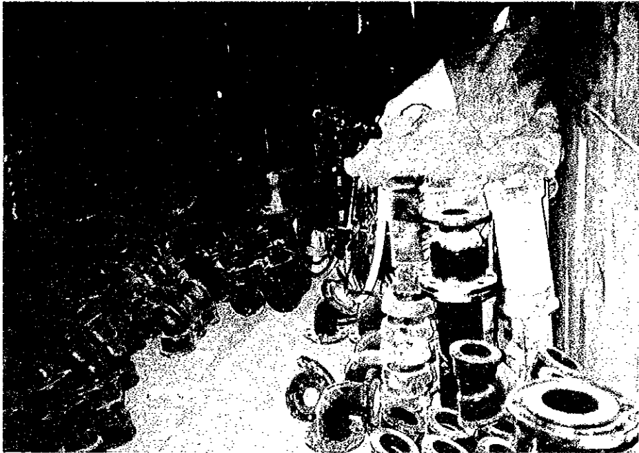
φ100ダクタイル鋳鉄管敷設現場の異形管置き場 (不許可居住地域)
