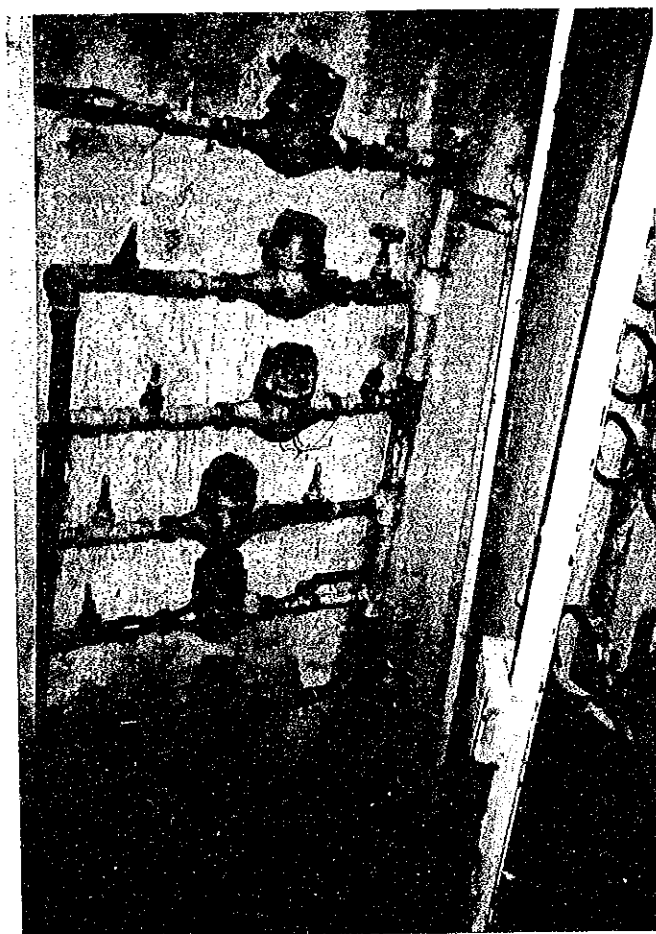
1/2インチサイズの 水道メータを 並列に設置している
