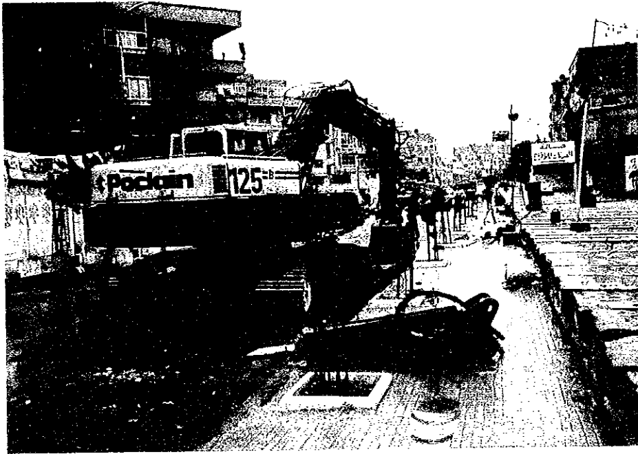
φ800ダクタイル鋳鉄管敷設現場（掘削機）
