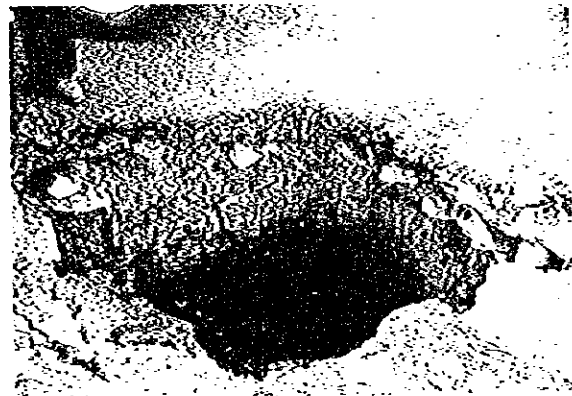
ドラゴンホール（増水による流砂が原因で崩壊）
