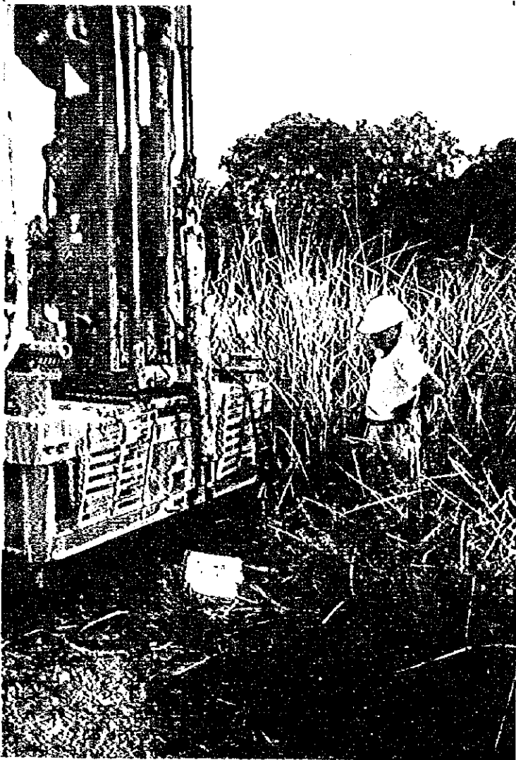
Foto N° T-4: Sitio Perforación P-T-4
