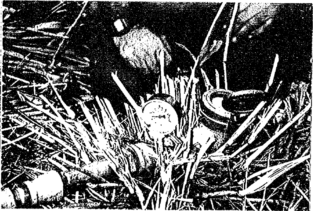
Foto N° T-10: Manómetro y Medidor de Caudal
