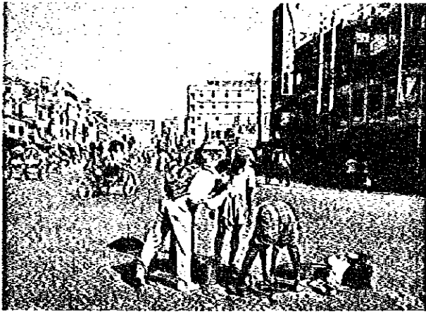
▲▶ 既設下水管路の清掃。すべて人手によって行われていた。
