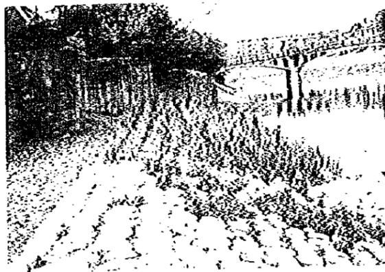
蛇籠護岸柳枝工および空石張護岸
