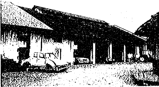
Nyerere整備工場は、収集車両・機材の主整備工場として利用される予定である。
