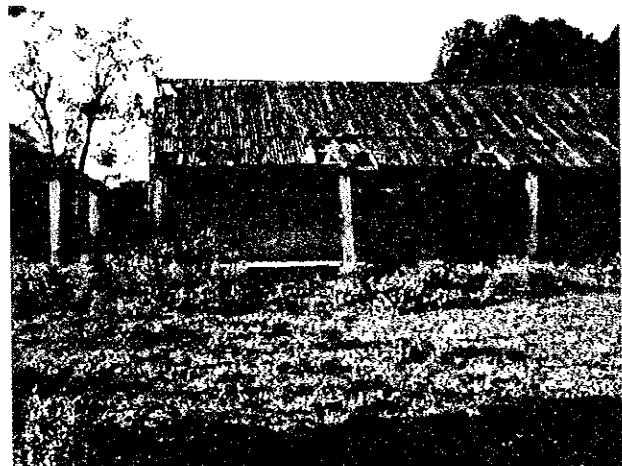
38. EBE DE BINAR (鉄板屋根の破損が著しい校舎)
