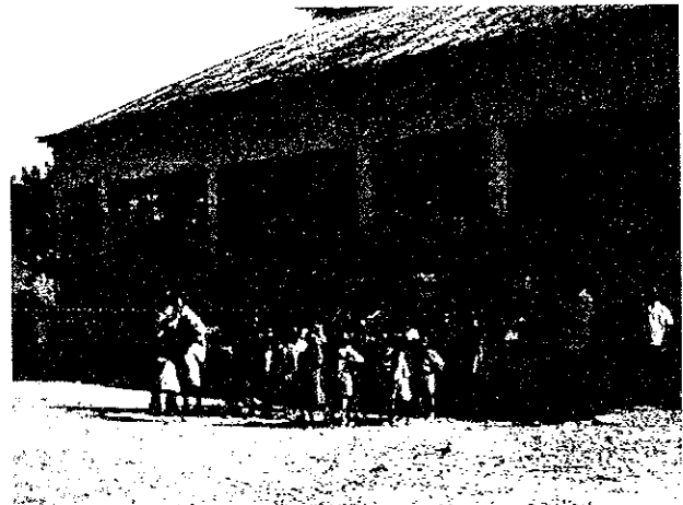
29. EBE RUI JASSI (ポルトガル統治時代に建設された校舎)
