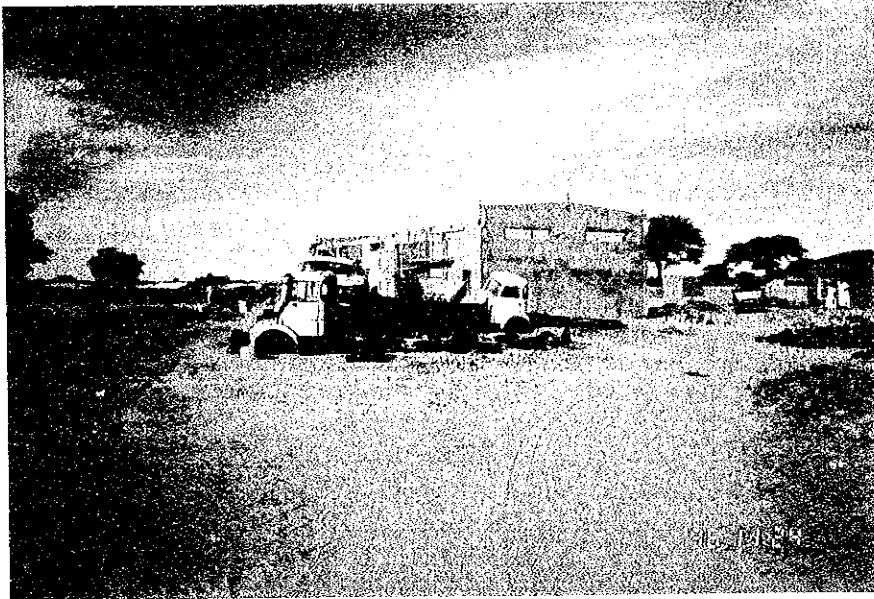
水利局KIFFA 地方事務所の状況 使用できる車輛はほとんどない。 後ろは外国援助で建設中の 修理用倉庫。
