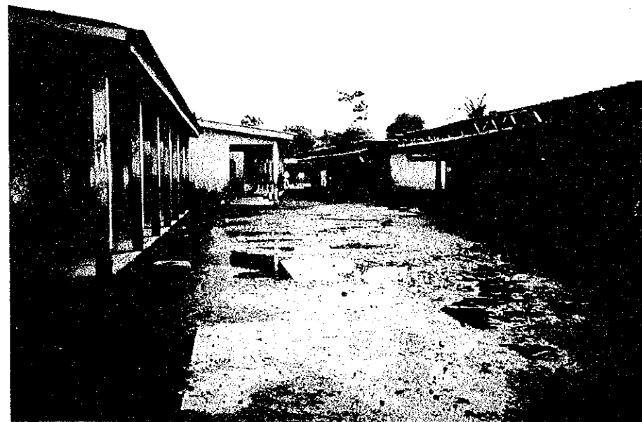
D24 EP.BONASSAMA 右手の建物は欧州基金により 60年代に建てられたプロトタ イプ教室。老朽化が著しく露 出した鉄骨柱や木造トラスの 損傷が痛ましい。
