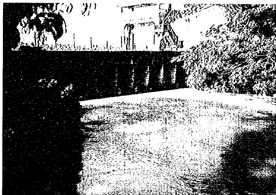
北部幹線水路側より取水工下流部を望む。
