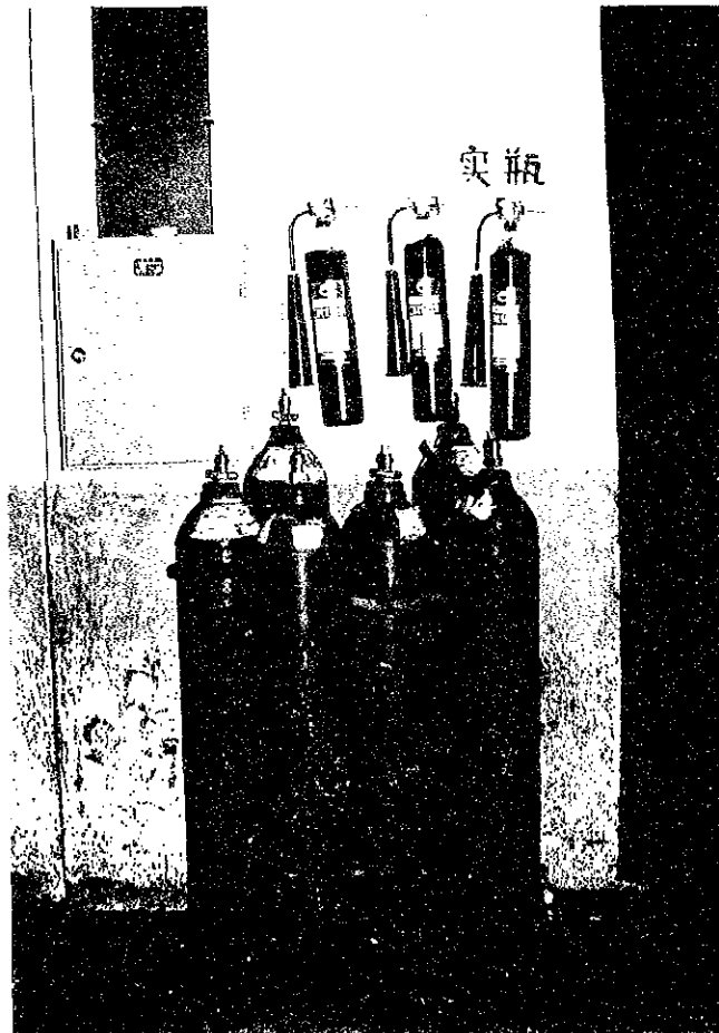
図6-7-11 転倒防止が施されていないガスボンベ
