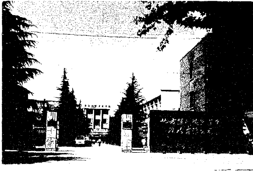
宝鷄北方照明電器工場正門
