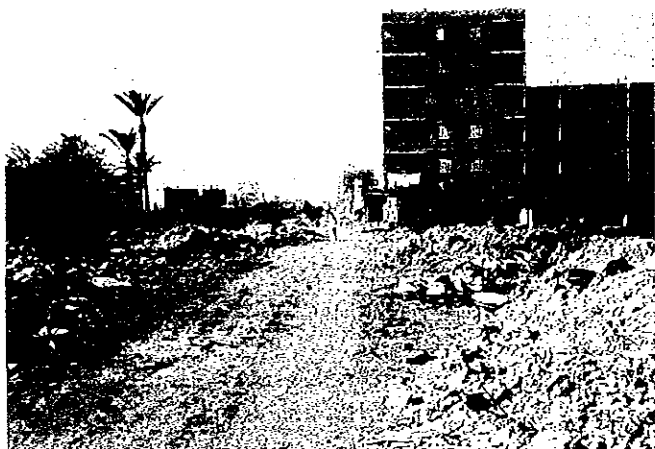
送水幹線布設ルートで最も距離の長い エル・オローバ通りの状況
