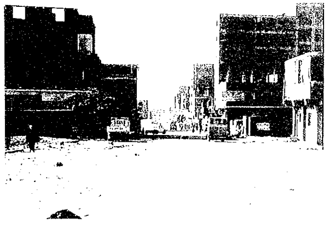
送水幹線布設の起点となる アダウィ・セリム通りの状況
