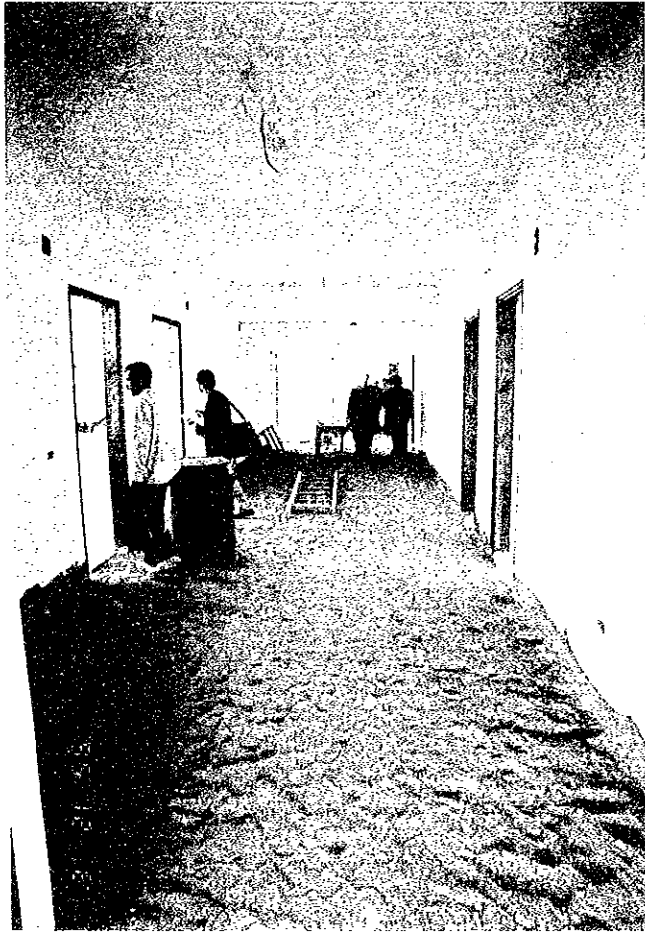
写真1：改装中のキット・カット訓練センター
