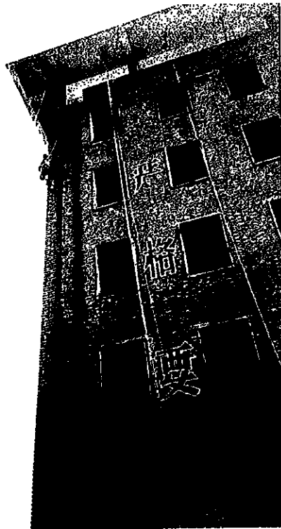
広州市消防学校の消防訓練塔
