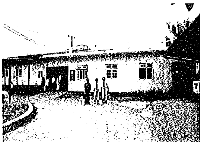
コロンボ南教育病院 大学ユニット（外科） 建設前
