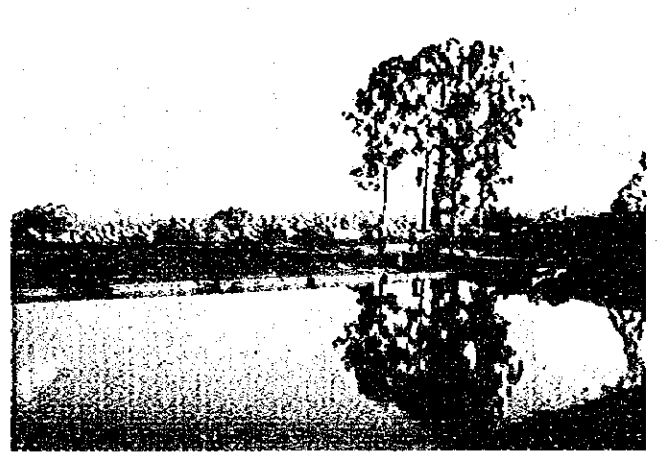
▲ メルー市 下水処理場
