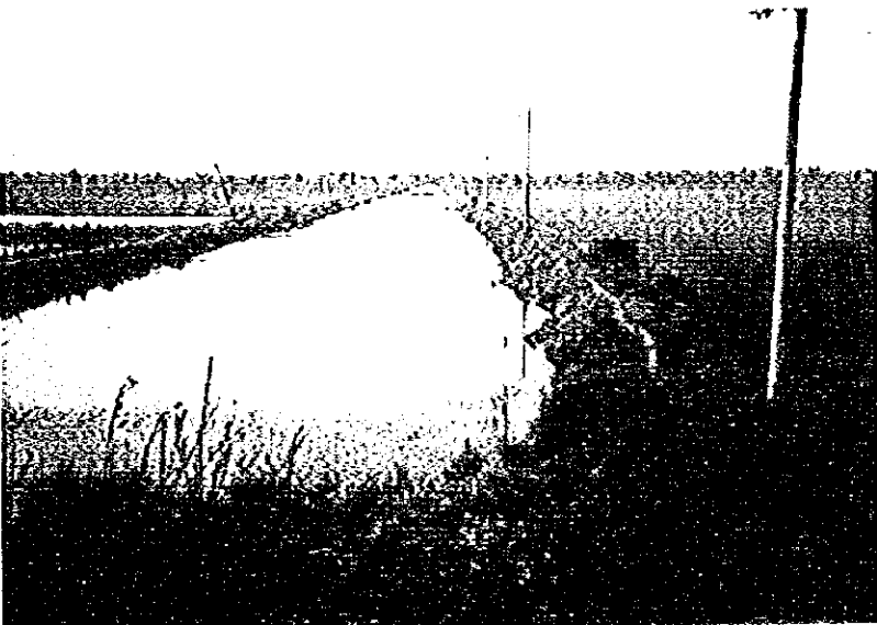
主幹線排水路 No.1 の起点付近、 排水不良のため、排水路が満杯 となっている
