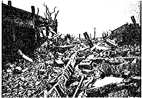
瓦礫となった小学校の跡
