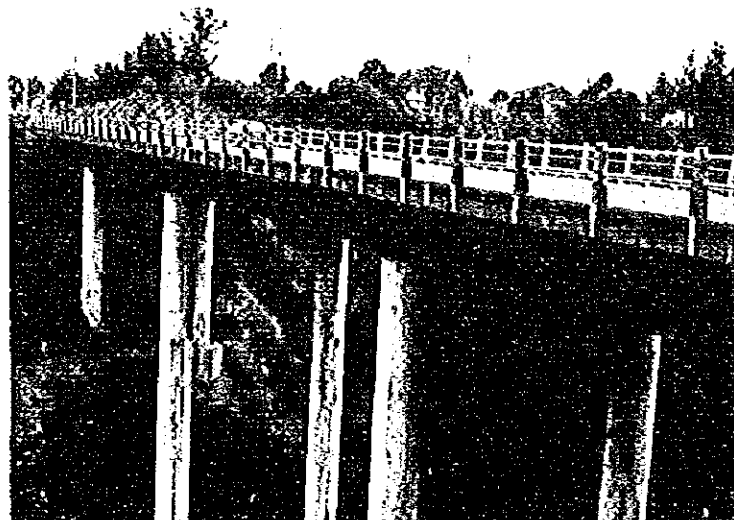
第5州内の橋梁。地震対策が十分ではない。
