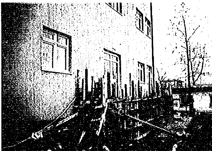
ブルサ・コミュニケーションセンター (建築中)
