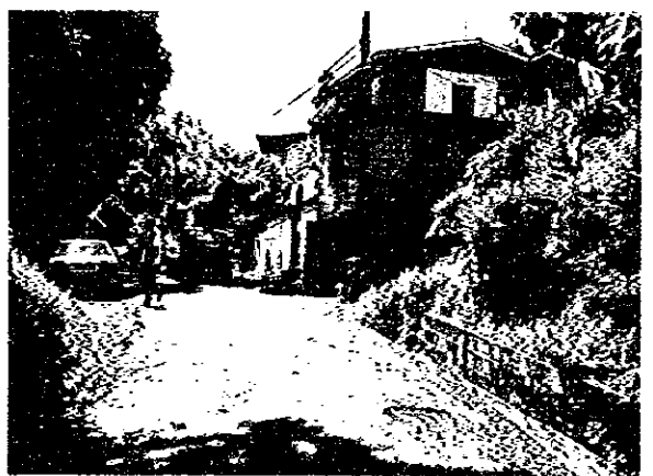
住宅が道路沿いに密集しているため拡幅の場合は住民移転が問題になるおそれがある。
