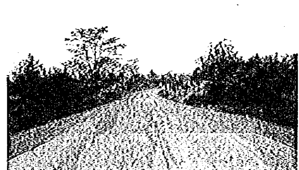
軟弱地盤地域の砂利道区間。プレローディング後にアスファルト舗装。
