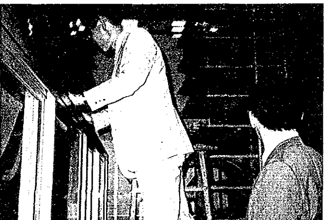
▲ボゴール局の古いMDF架(勝手に切断、入替ができないよう、背の高さまでガラスの履いがかかっている)
