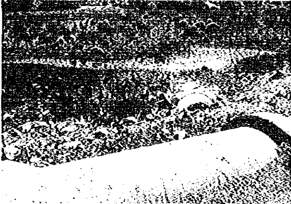
写真-7. ラグーンへの下水幹線（手前） とラグーンからの放流管
