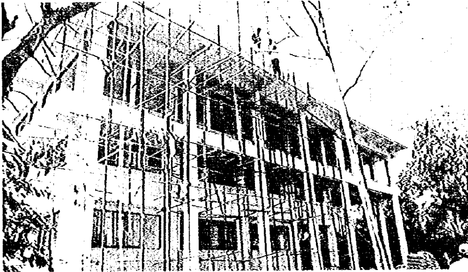
完成間近のバイオテクノロジービルディング
