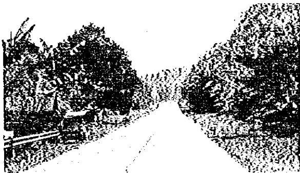
1-1 ブツアン～カガヤンデオロ～イリガン道路 平地部の状況
