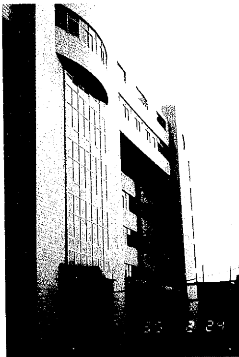
無錫市に建設中の分析センター
