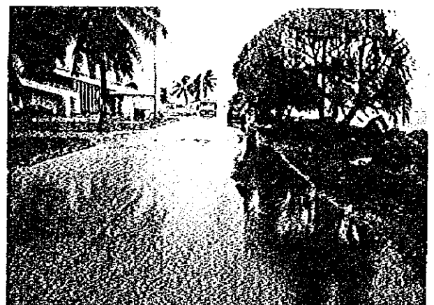
Km 16-300 (マジロ空港付近)
