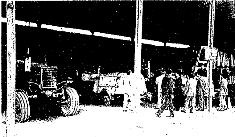
建設機械実習
