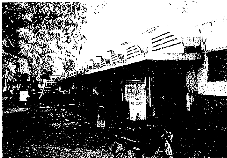
機械・金属加工実習場全景
