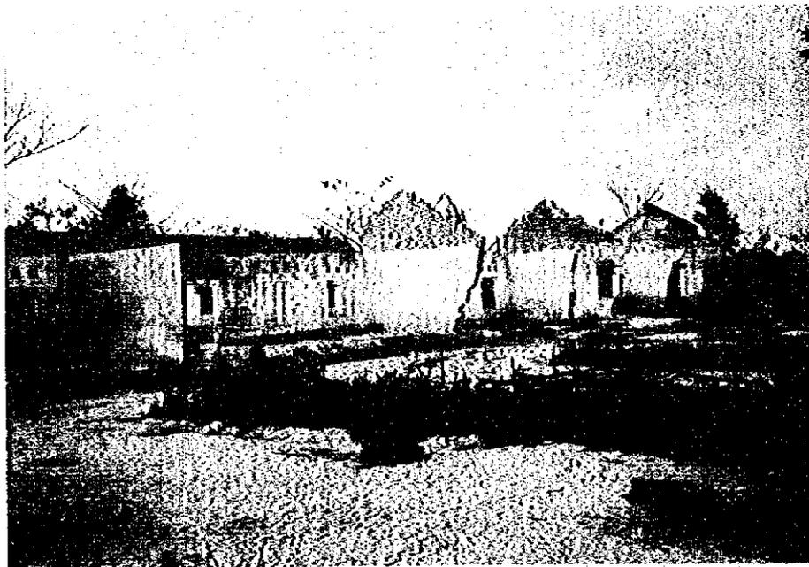
●95年の台風で全壊した建物。きれいに屋根と壁がとばされている。現在の標準仕様はこのように台風に対して耐性がない。
