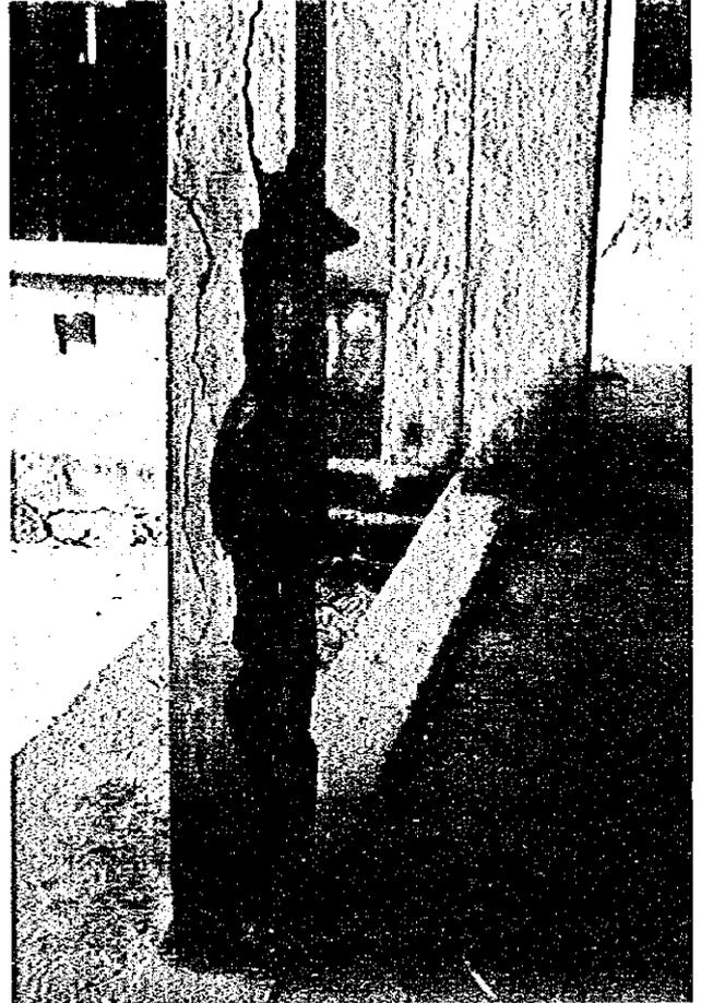
●鉄筋コンクリートの柱。コンクリートの質、かぶりの不足からモルタルやコンクリートが剥落している。
