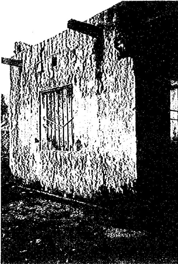
●台風により屋根が崩壊した校舎が放置されている。壁面の汚れから冠水時の水位が読める。
