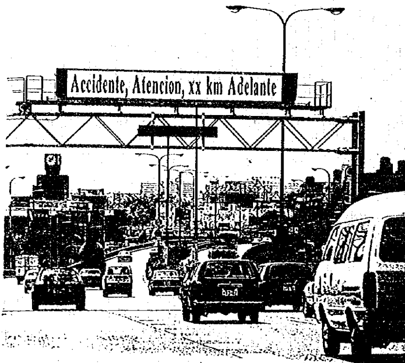
Figura 13.2-16 Panel de señales de Mensajes Variables
