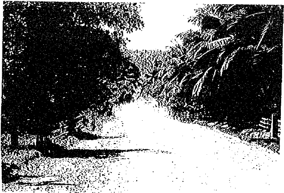
南東スラウェシ州ケンダリ市から110km付近の道路の状況
