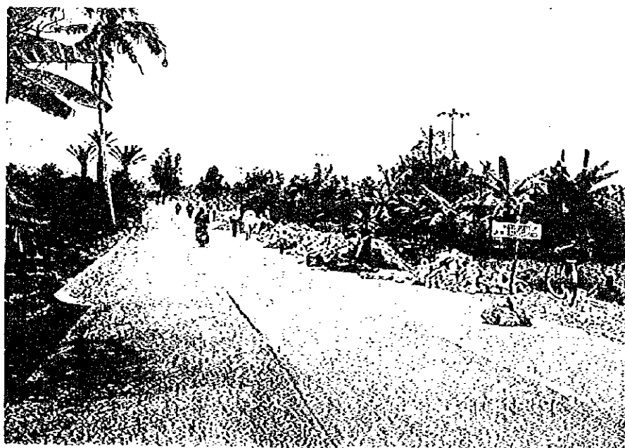
南東スラウェシ州ケンダリ市から35km付近の 道路改良工事の状況
