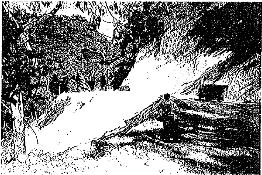
中央スラウェン州 Toboli-Tawaeli 間道路の 斜面崩壊状況 (Tawaeli 側)
