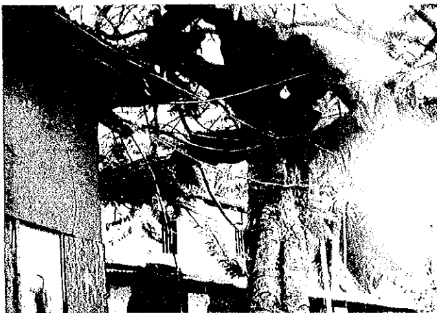
ミドゥー地区の架空配電設備（配電設備はマレ島で使用済のMEBの架空線資機材を私企業に供与し、敷設したものであるが、MEB基準の地中埋設ケーブルではないこと、また配電容量が不足しているので需要家の多くは電圧降下に悩まされ極めて深刻な状況にある。）
