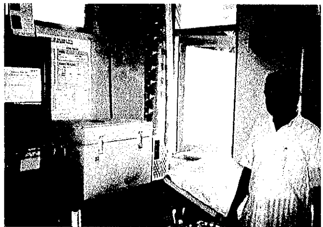
ミドゥー地区診療所（受電時間も制限されかつ電圧降下のためワクチン用冷蔵庫も使用できず、コンセントが抜かれていた。代替品として太陽光発電による冷蔵庫を使用しているものの小容量なため不十分とのことである。）
