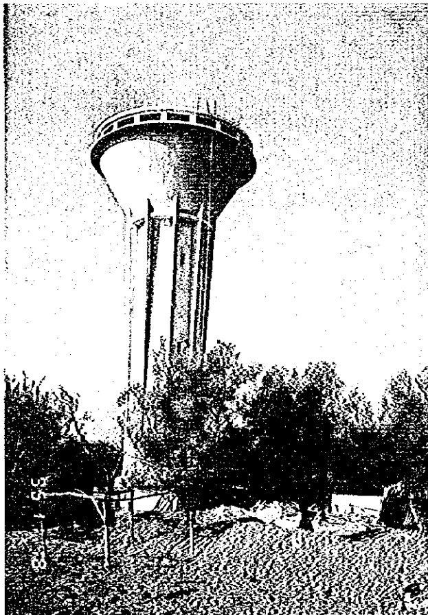
高架式配水槽
