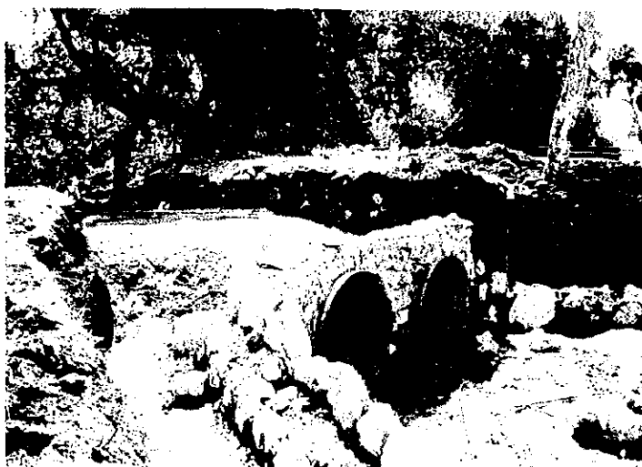
Revista de Ruta 417 em Chivalo Inhambane. Anda reparação de drenagem.
