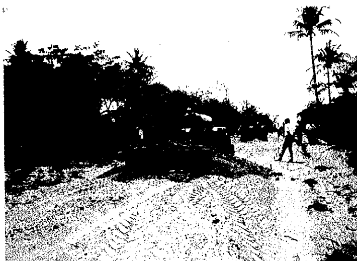
Revista de Ruta 416 em Mucodoene Inhambane. Trabalha de reconstrução de via com pavimento de terra Laterite.
