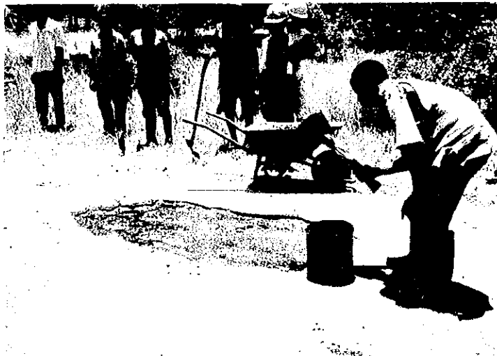
Reparação de buraco de pavimento asfaltado, depois de pintar Tac- Coat, repor material Cold- mix, regar arena afinal.
