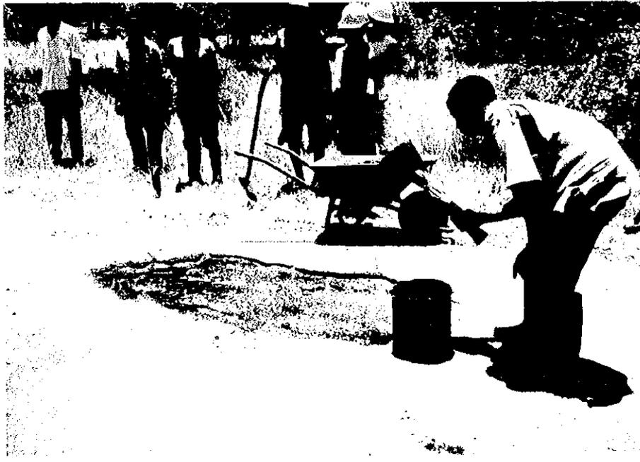
同上 ポットホールにタックコートを手作業で塗布中、塗布後コールドミックス材を散布、アスファルト塗布後、砂を散布して仕上げる
