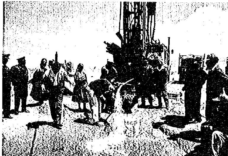
Pumping test (Patacamaya)
